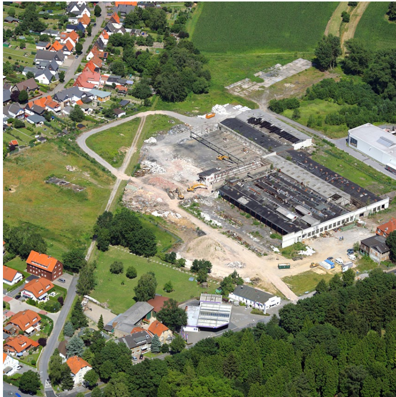
Ehem. Werksgelände der Fahrradfabrik UNION, Werl
