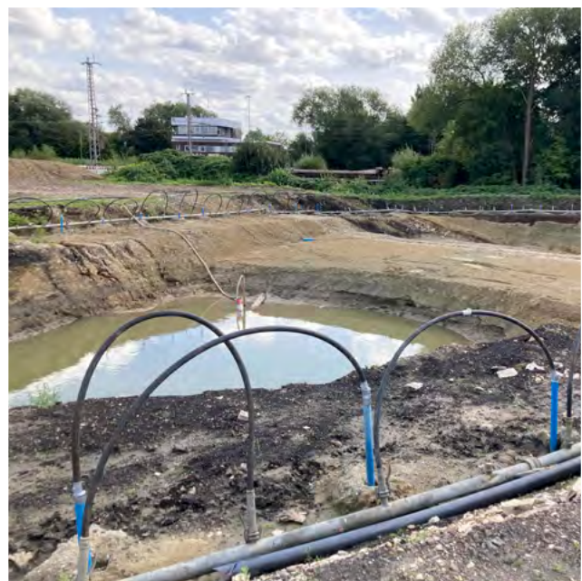
▲ Das neue Regen-Rückhaltebecken entsteht.
