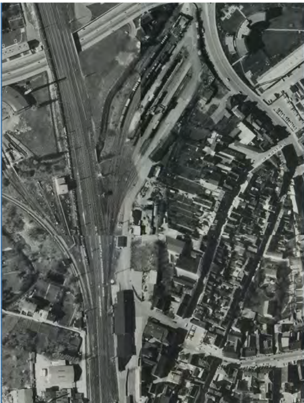
▲ Blick auf den historischen Güterbahnhof.
