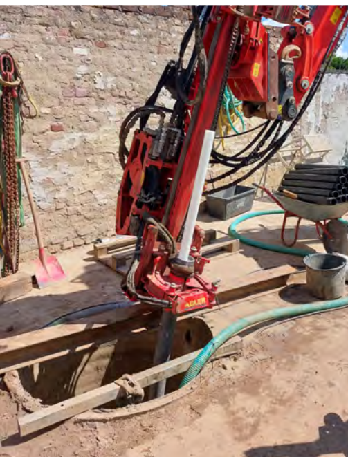
▲ Bohrung eines der Brunnen.
