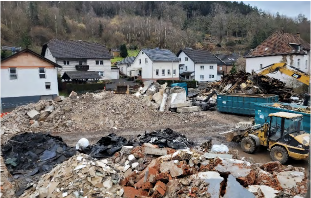
▲ Zu solchen Haufwerken wurden die unterschiedlich belasteten Materialien beim Rückbau separiert.
