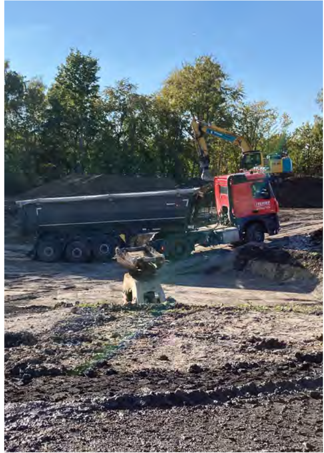
▲ Belasteter Boden wurde abgefahren.
