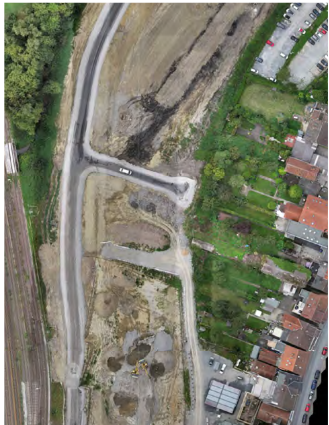
▲ Blick auf die Brache während der Sanierung.
