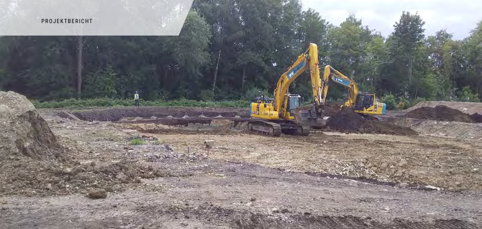
▲ Auffüllungen mussten großflächig entfernt werden.
