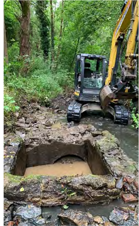
▲ Zulauf Schachtbauwerk im Oberstrom.
