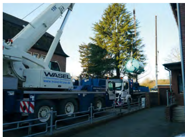
Anlieferung der neuen Grundwasser-Sanierungsanlage
