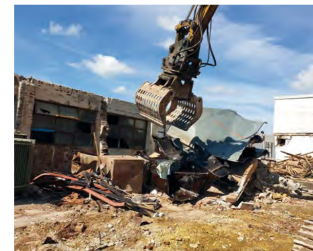
Rückbau des Betriebsgebäudes
