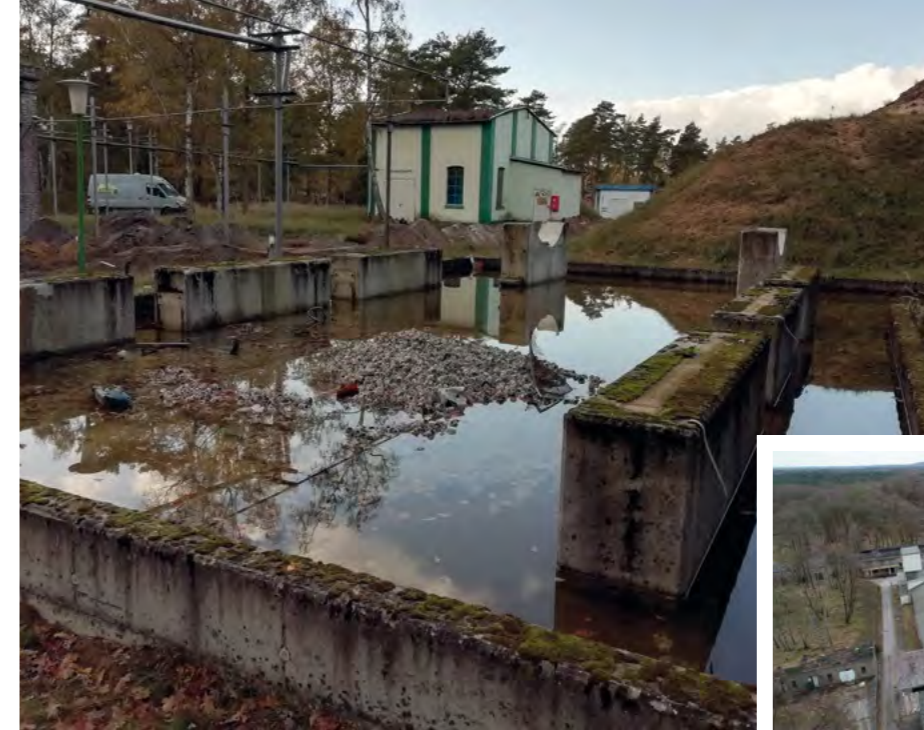
Altstandort der Aceton-Tanks – im Hintergrund das Wasserwerk
