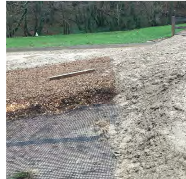
Einbau von Geogitter
