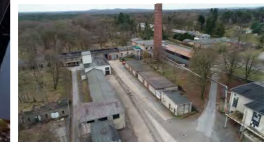
Salzmühlen mit Rohstofflager und Kraftwerk
