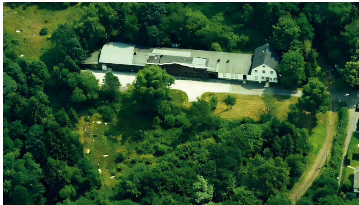
Der ehemalige Betrieb aus der Luft gesehen
