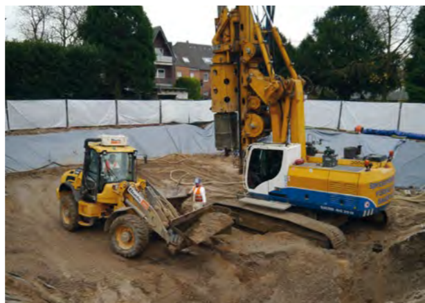
Großlochbohrung (2013/14)
