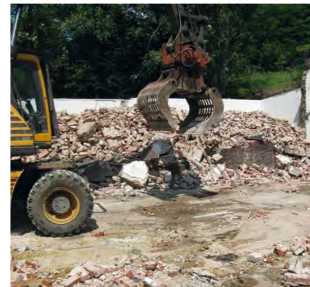
Rückbau des Betriebsgebäudes
