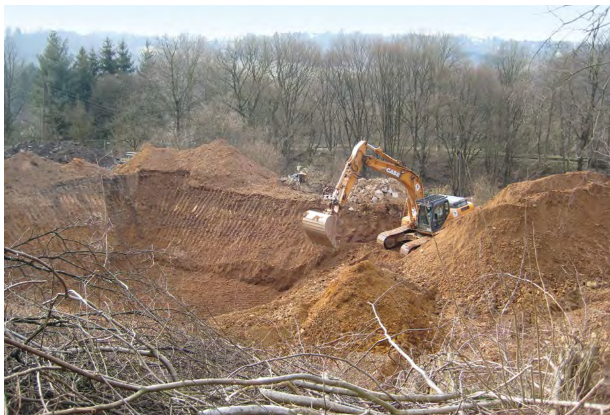
Bodenaustausch bis zum Fels
