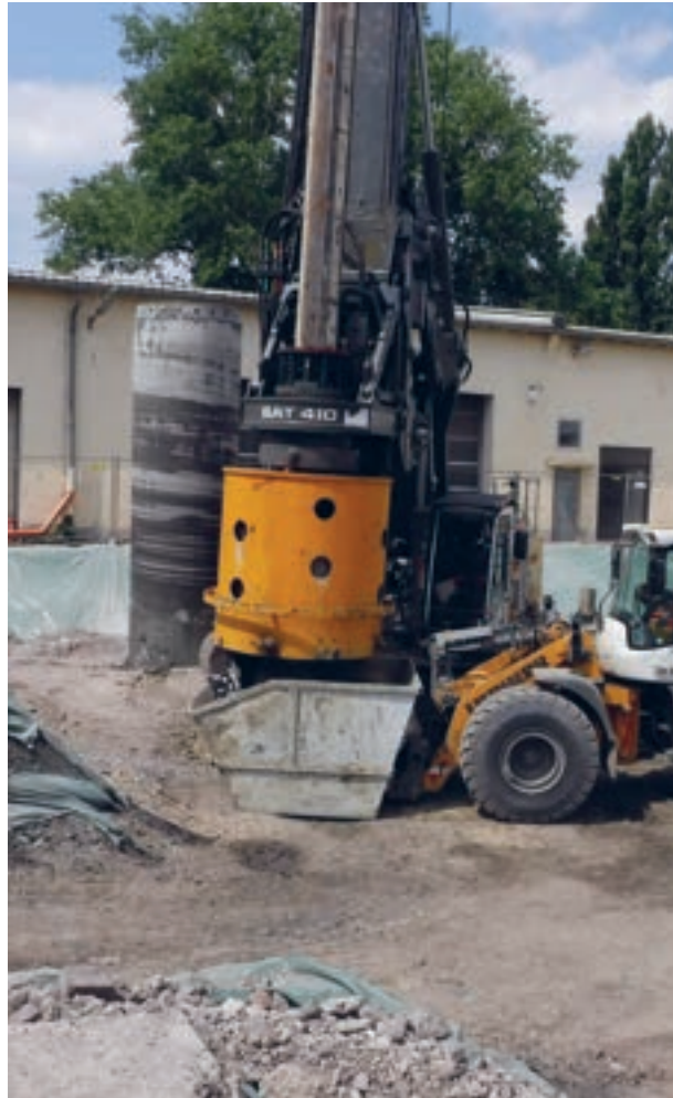
Bodenaustausch im Großlochbohrverfahren
