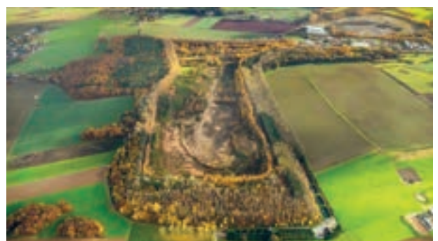
Luftaufnahme von der Bergehalde Beythal
