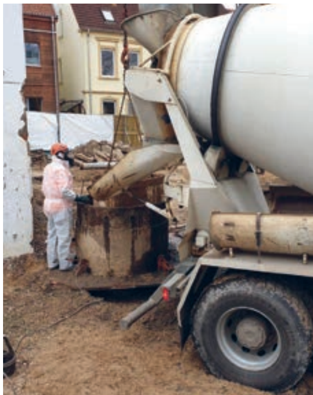
Einbau von Flüssigboden
