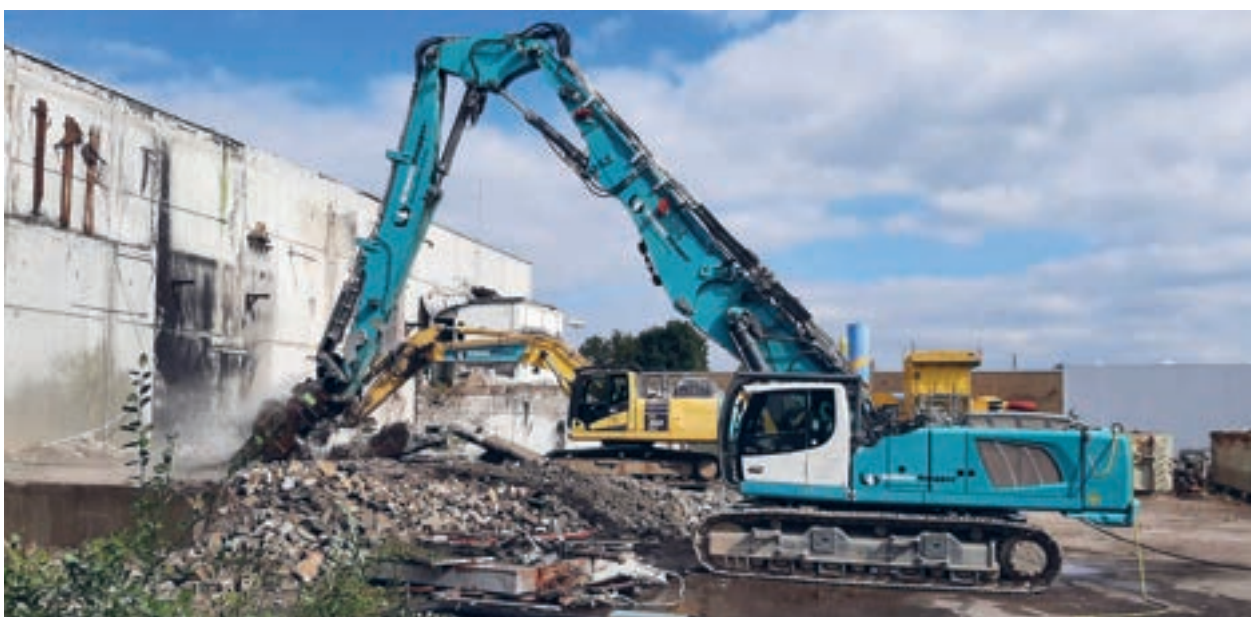
Der Rückbau des Betriebsgebäudes erfolgte mit einem Longfront-Bagger
