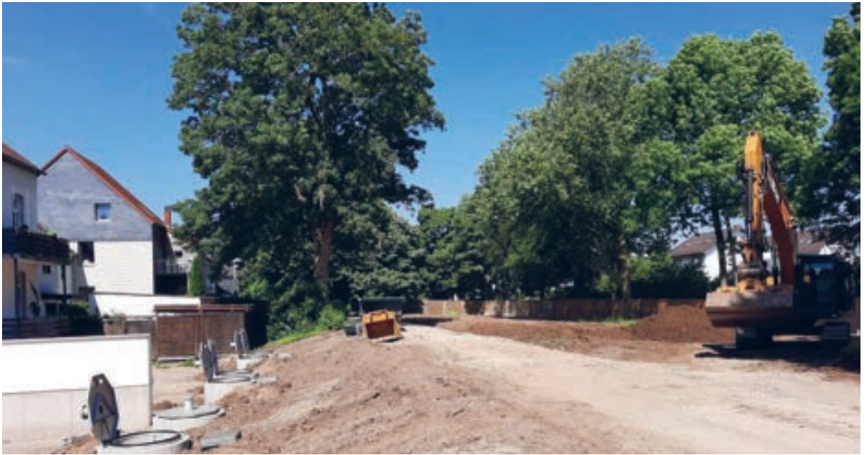
Wiederherrichtung der Parkanlage
