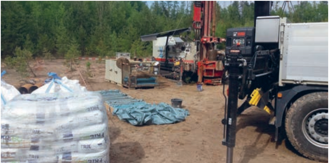
Bohrungen auf dem Haldenplateau mit Kerngewinnung
