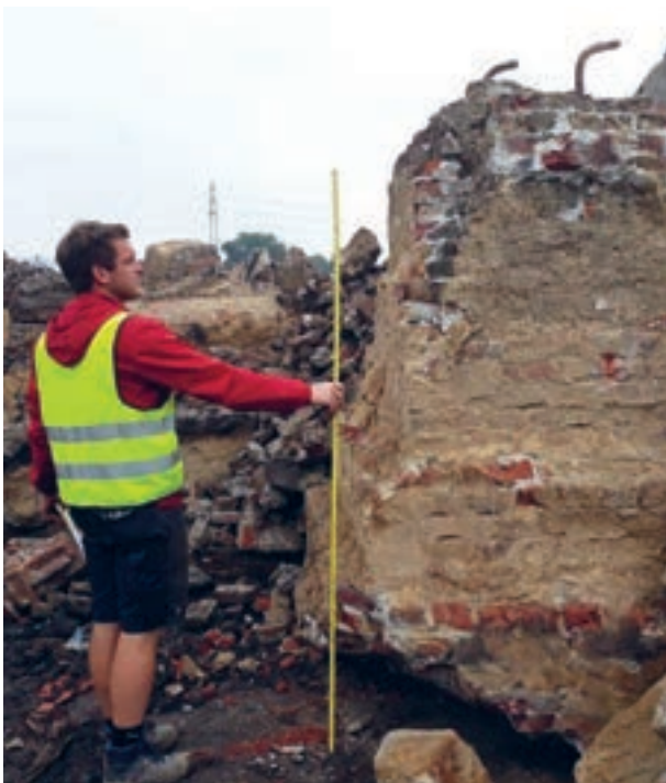
Mächtige Fundamente waren zu entfernen
