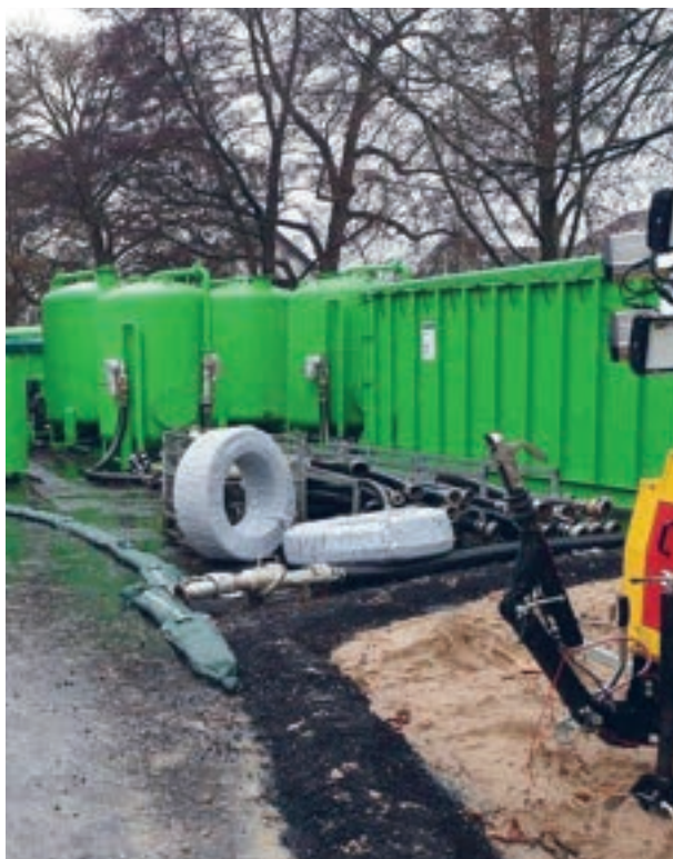
Grundwasserreinigungsanlage
