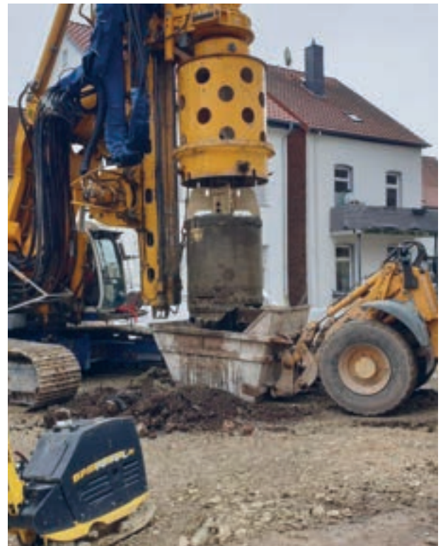
Bodenaustausch im Großlochbohrverfahren
