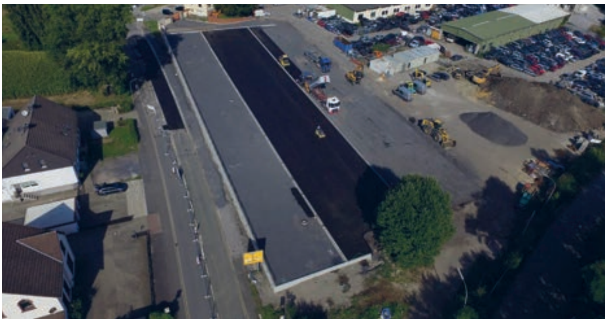
Wiederhergestellte Fläche nach Rückbau und Bodensanierung
