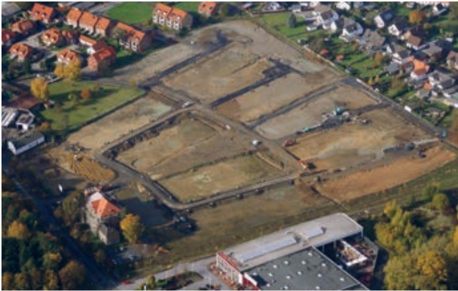
Das Gelände nach der Sanierung
