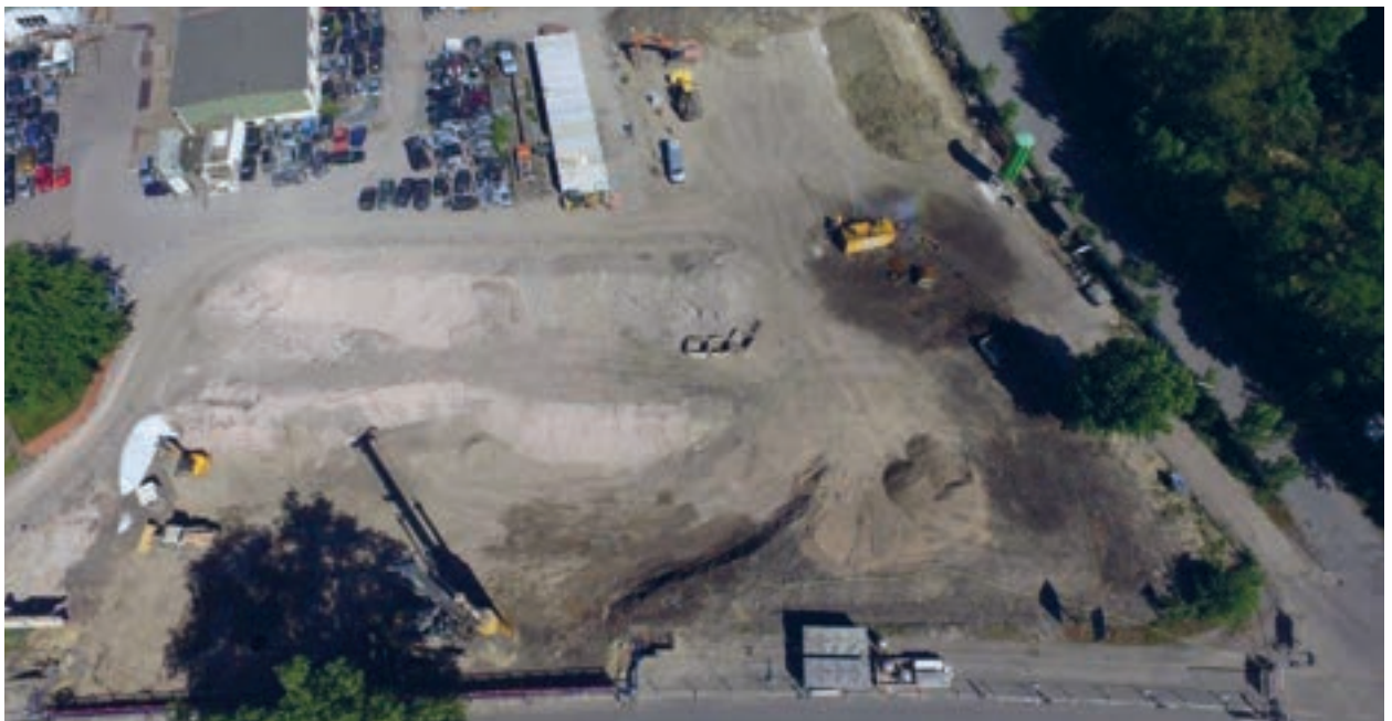
Luftbild der Baustelle in Unna-Massen
