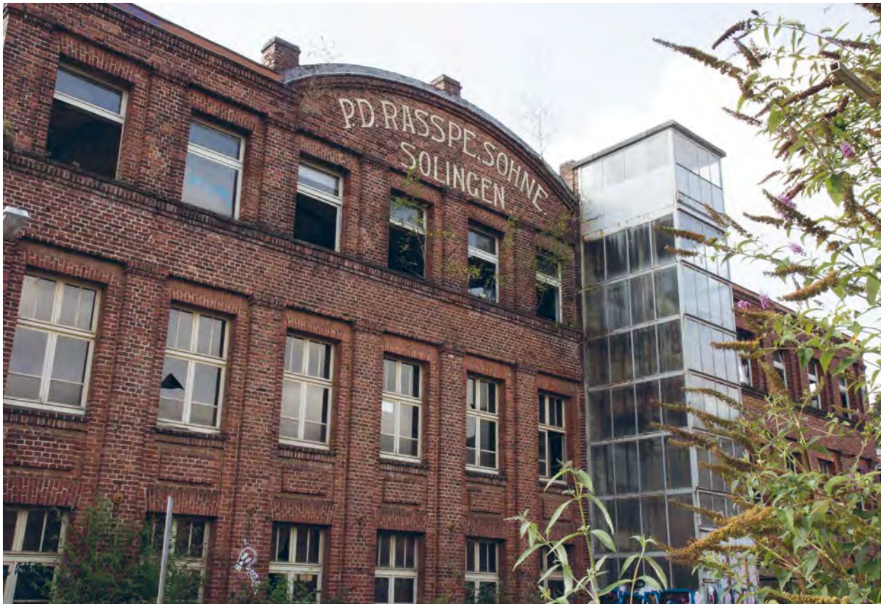
An einem der Gebäude steht noch der alte Firmenname
