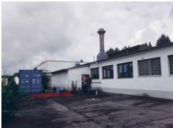
Betriebsgebäude mit Grundwassersicherungsanlage
