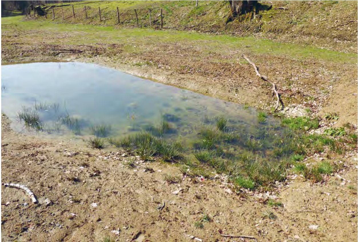
Der angelegte Teich etwa ein Jahr nach der Sanierung
