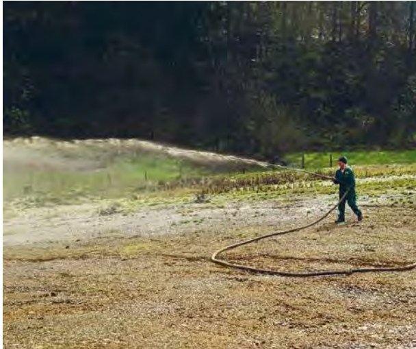
Ausbringung der Begrünungslösung zur Herstellung von Magergrünland
