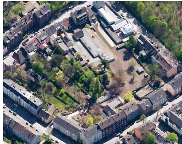
Durch die geschlossene Randbebauung konnten die Gärten in der Sanierungszone II nur durch zwei enge Durchfahrten erreicht werden. Auf der rechten Seite ist der Boden schon wieder angefüllt, in der Mitte ist gerade der Aushub im Gange.
