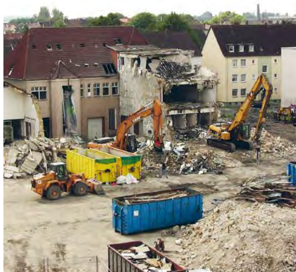
Rückbau der Gebäude
