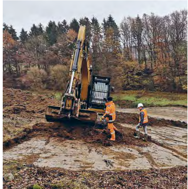
Bodenabtrag im Vor-Kopf-Verfahren im November 2019
