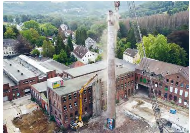
Der Kamin wurde mit einem Spezialbagger zurückgebaut
