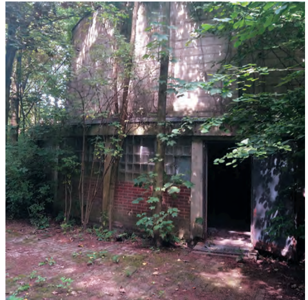
Alte Kläranlage in Sendenhorst
